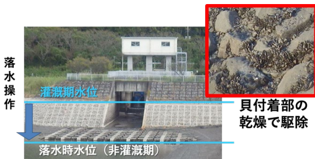
図3 落水管理によるカワヒバリガイの駆除技術
