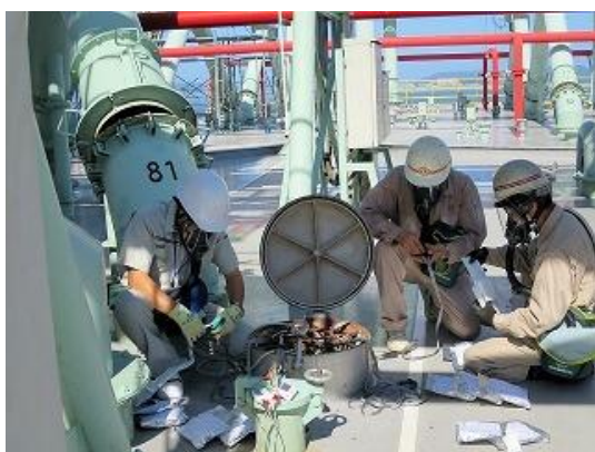
図8. リン化アルミニウム残渣取り出し 状況
