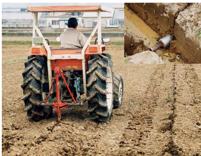
図2-1-7 弾丸暗渠施工とドレーナ（右上）
