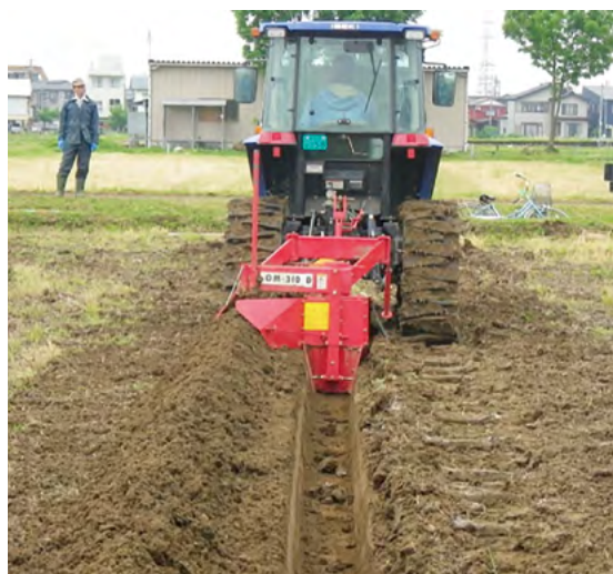
図2-1-6 周囲明渠施工
