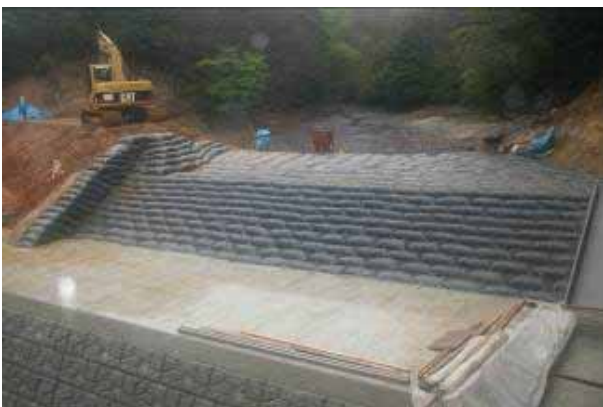
写真2 平田ため池における越流許容型ため池工法の適用状況 (左:土嚢設置状況,右:ソイルセメントによる覆土処理後)
