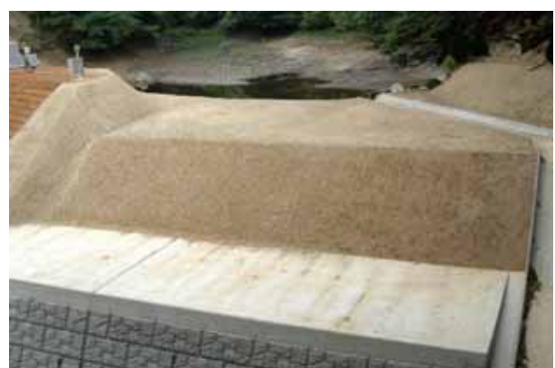
写真2 平田ため池における越流許容型ため池工法の適用状況 (左:土嚢設置状況,右:ソイルセメントによる覆土処理後)
