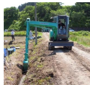
図 4 用排水路内土砂掘り上げ機
