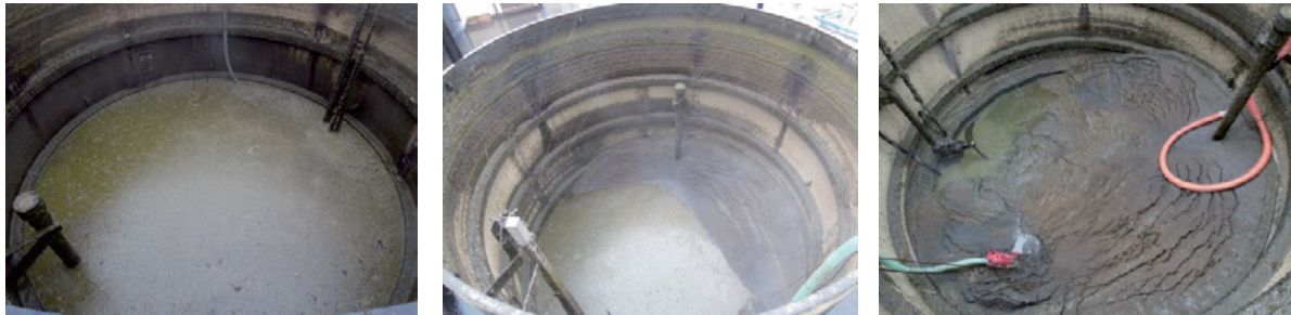
発酵槽内の液の排出による水位の変動の様子（左および中：作業途中の発酵槽の様子，右：排出終了後の様子）
