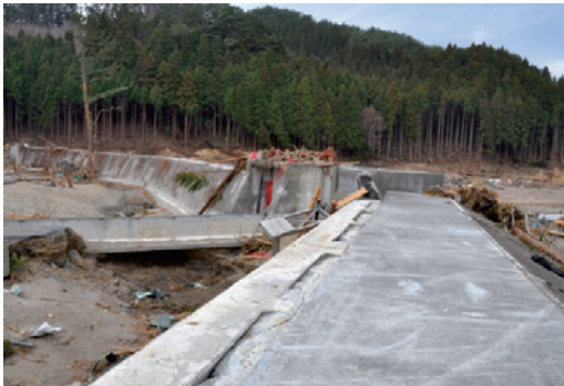
Fig.8 津波によるパラペットの飛散（岩手県） Dispersion of parapet by a tsunami (Iwate prefecture)
