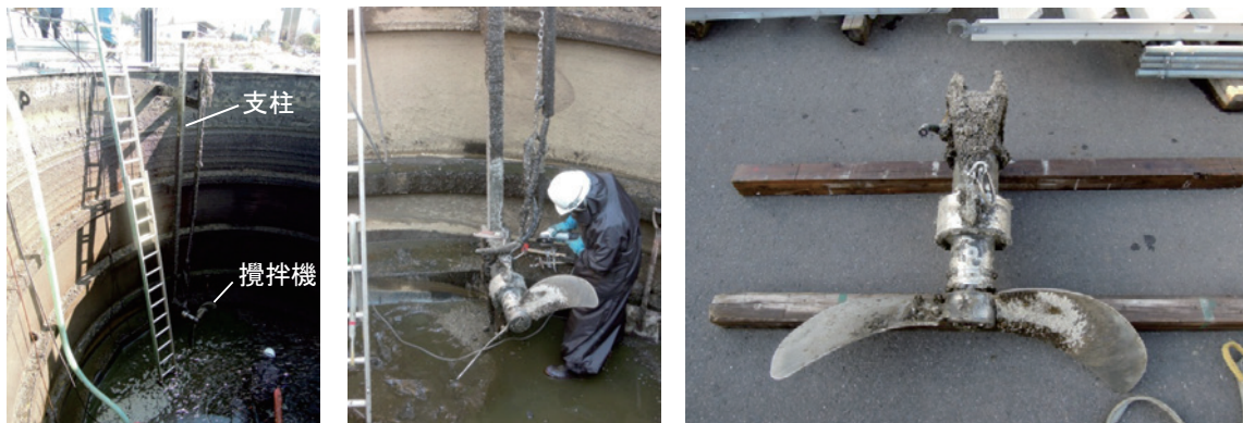
攪拌機の取り外し作業（左：攪拌機の設置位置，中：攪拌機の取り外し作業，右：取り外した攪拌機）
