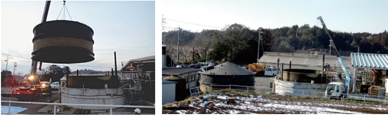
発酵槽の屋根の取り外し作業（左：クレーンによる吊り上げ，右：取り外し後の発酵槽）
