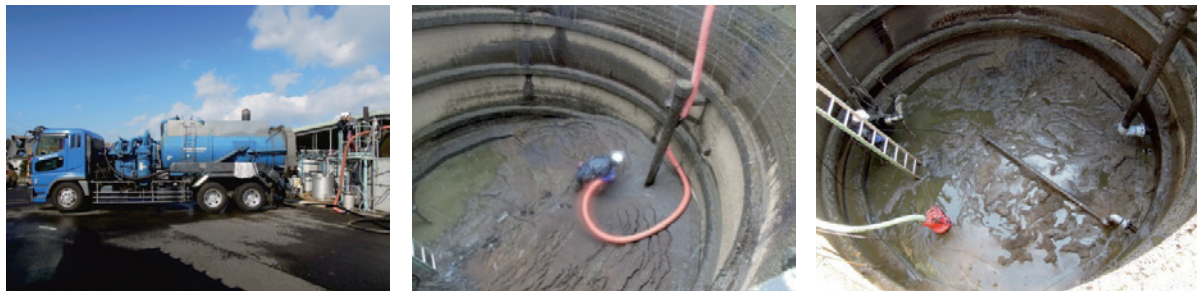
発酵槽の底部堆積物を吸引し、除去している様子（左：吸引車，中：堆積物の吸引作業，右：作業後の様子）
