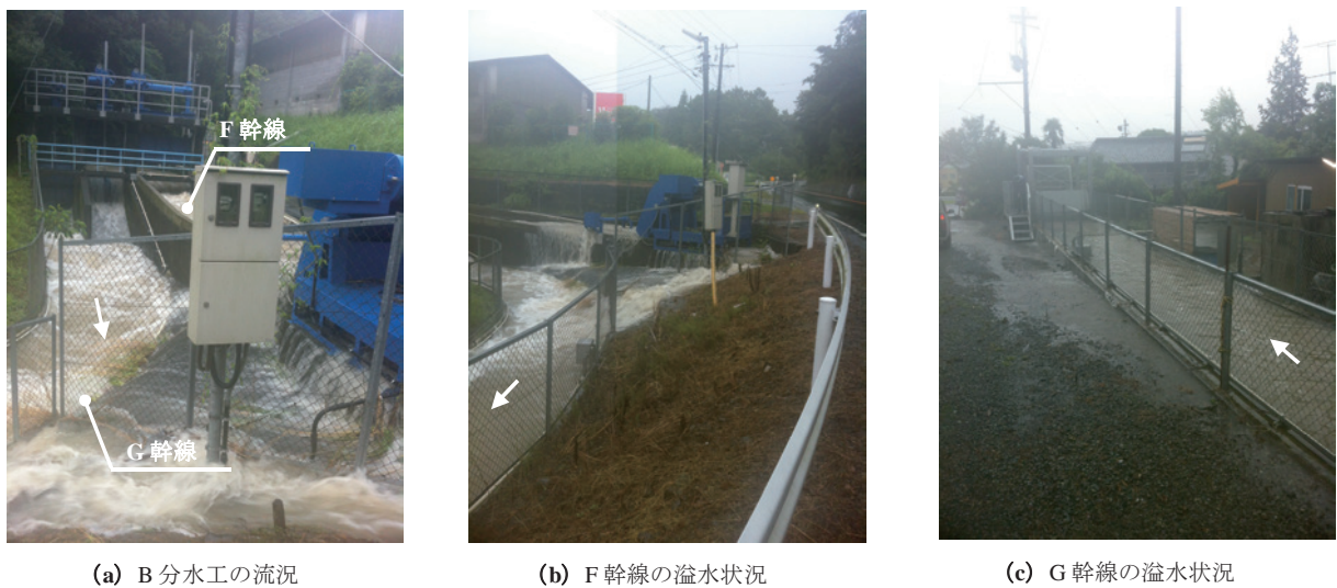
Fig.5 B 分土工下流の現場における溢水状況の写真 (2012/8/14 9:00) (a) B 分土工の流況, (b) F 幹線の溢水状況, (c) G 幹線の溢水状況
