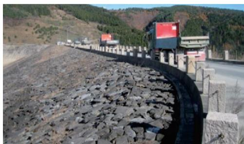
Fig. 25 流入土砂排土運搬用のダンプカー
