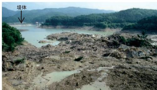
Fig. 24 貯水池に流入した崩壊土砂
