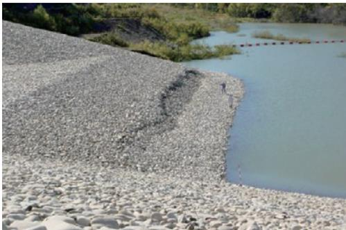
Fig. 10 右岸地山ブランケット保護層の被災
