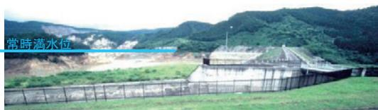
Fig. 23 貯水池越しの左岸上流地山の山体崩壊
