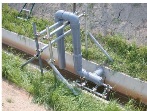
図2-2-18 雨竜町のサイホン式地下水位制御装置
