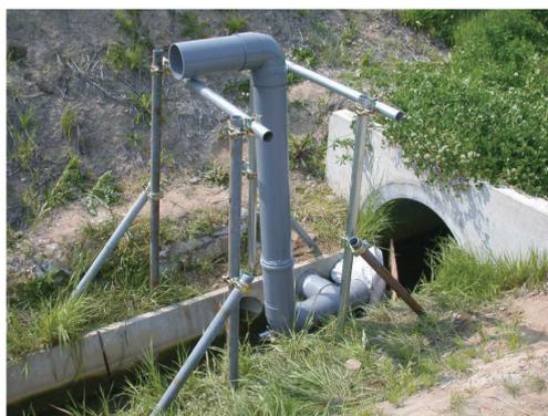
図2-2-17 雨竜町の溢水式地下水位制御装置
