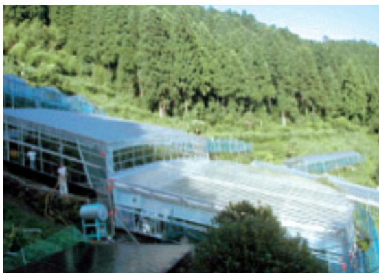
図2 段畑地形に対応した平張型傾斜ハウス
