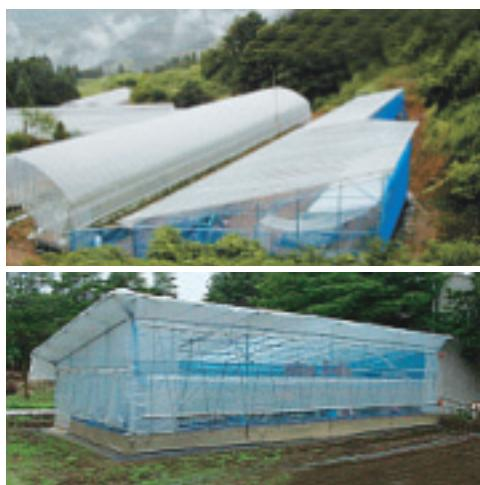
図11 開発した片屋根片ハウス
