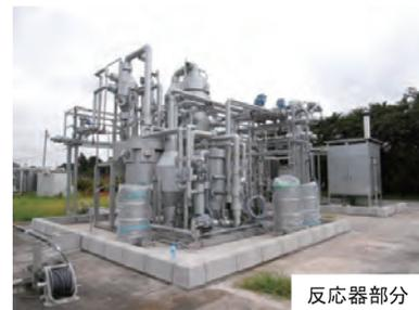
図2.実証プラントの外観（設計製造能力:400 L/日）
