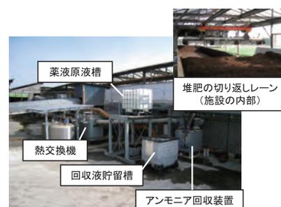
図2.酪農家(搾乳牛120頭規模)に設置した吸引通気式堆肥化処理システム
