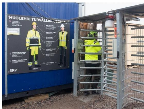
図2 建設現場での作業管理システム概要（左）と出入口でのシステム（右）
