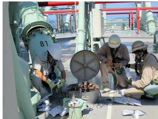
図20 リン化アルミニウム残査取り出し状況
