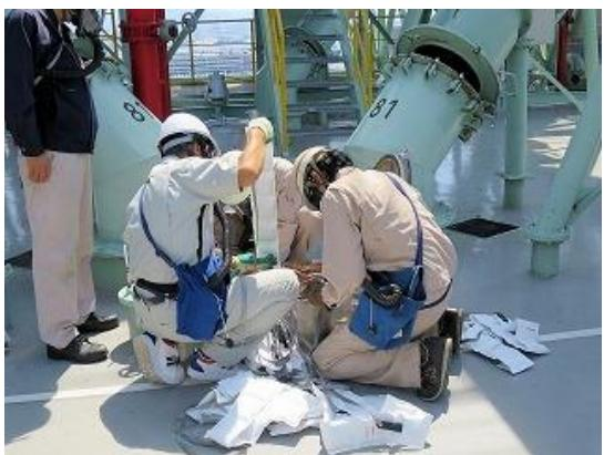
図19 リン化アルミニウムの投薬状況
