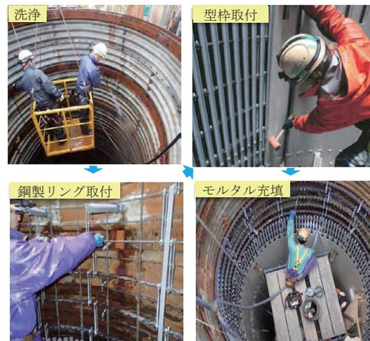
図 内巻工法の施工手順
