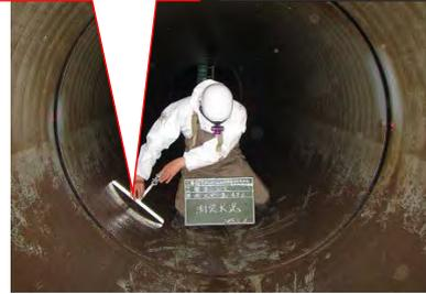
図 現場でFRPM管の曲率半径を計測している様子
