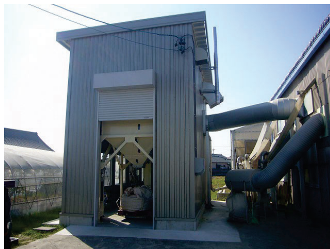
粃殻燃焼装置建物 (新設)
