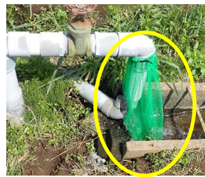
給水栓への収穫ネット取り付け例
