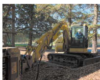
抜根には大型の機械を用います。
