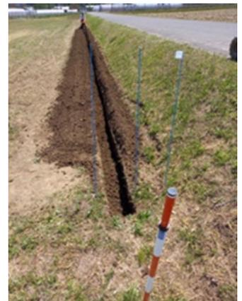
本暗渠を 10m間隔に施工し、暗渠と直角にサブソイラーで弾丸暗渠を施工するとさらに効果的です。
