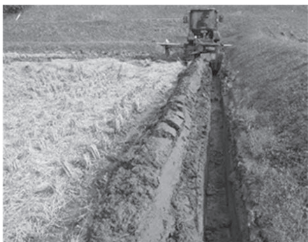
写真1 額縁暗渠の施工
