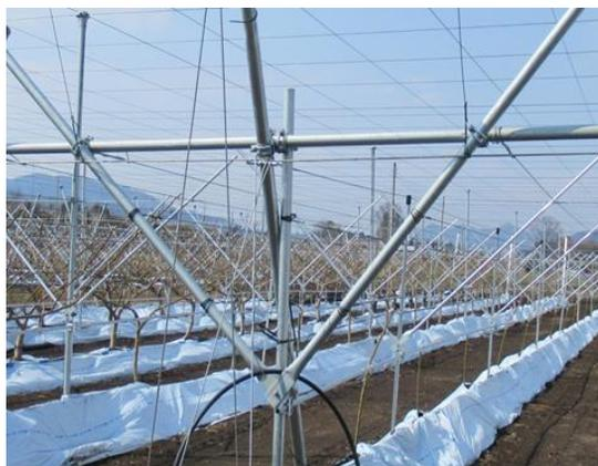
部材削減とパイプ固定部の扁平化による強化で自己施工が可能な専用棚を開発
