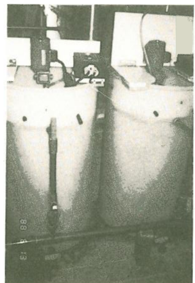
西ドイツHelgoland国立海洋研究所内海水ろ過装置
