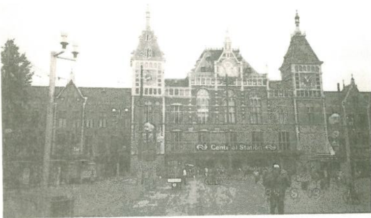
東京駅のモデルにもなったアムステルダム中央駅
