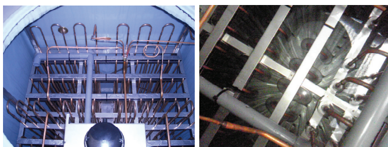
図 3-15 蓄熱槽内の CO 2 冷媒用伝熱管と生成された氷
