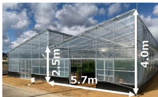
アスパラガス向け片屋根連棟型ハウス NNハウス(香川農試・農研機構)
