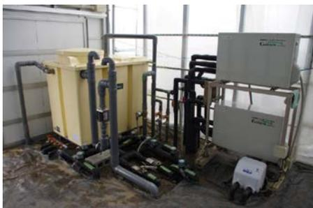
写真1 地下水熱源ヒートポンプシステム
