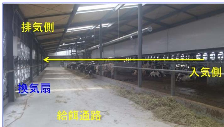
図1 閉鎖型プッシュ&プル横断換気牛舎
