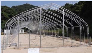
耐雪型2重アーチハウスの導入
