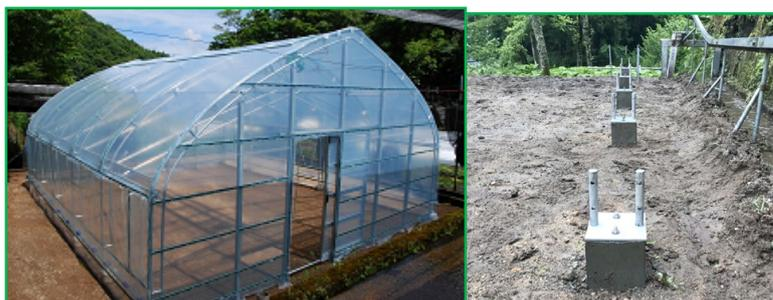
図3 わさび田に導入した2重アーチ構造パイプハウス（左）と簡易基礎(右)
