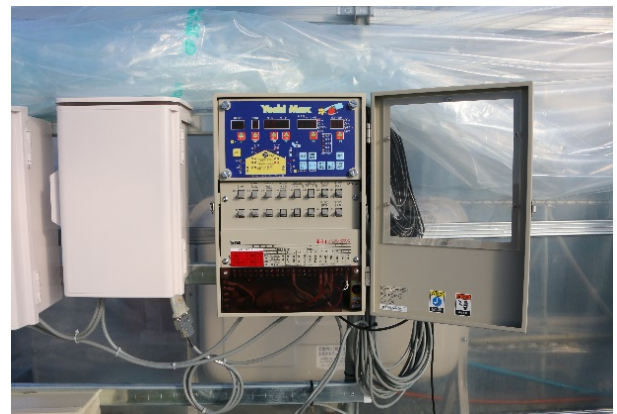
写真 3 UECS 対応の YoshiMax (左のボックス内の Raspberry Pi で UECS に対応)
