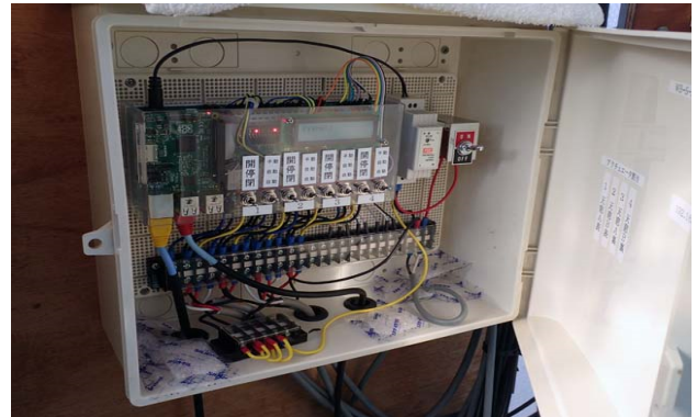
写真 2 写真 1 の既存制御装置を UECS 対応低コスト環境計測制御システムでリニューアルした例
