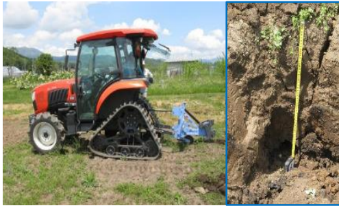
写真2 カットドレーンmini 施工の様子と形成された通水空洞
