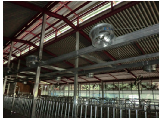
写真2 ICTを用いた暑熱管理
