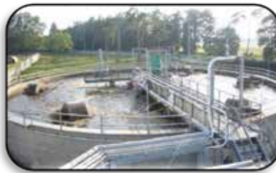
豚舎排水浄化施設
