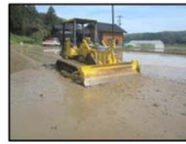
水整地による均平化施工 (湛水状態で整地)
