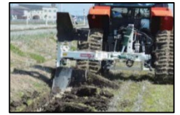
溝掘り (リバーシブル)
