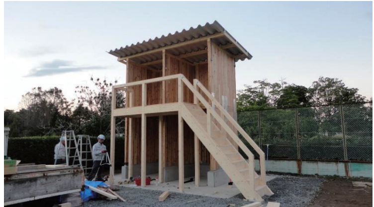
写真4 CLTパネル工法の施工試験建物
