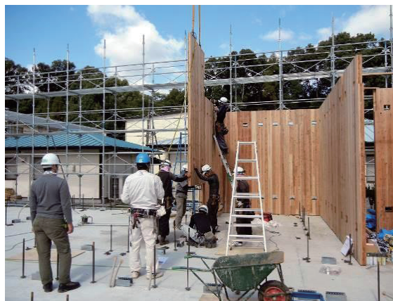
写真 2 CLT 建築物の施工現場状況
