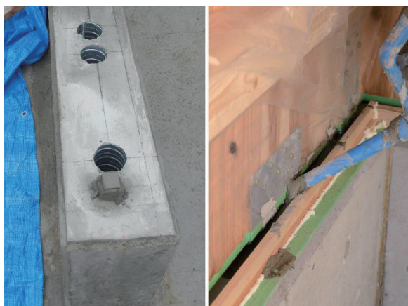
写真 1 逆差しアンカー工法の施工
