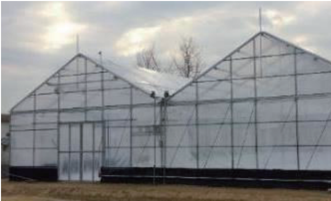
図2 連棟型建設足場パイプハウス
