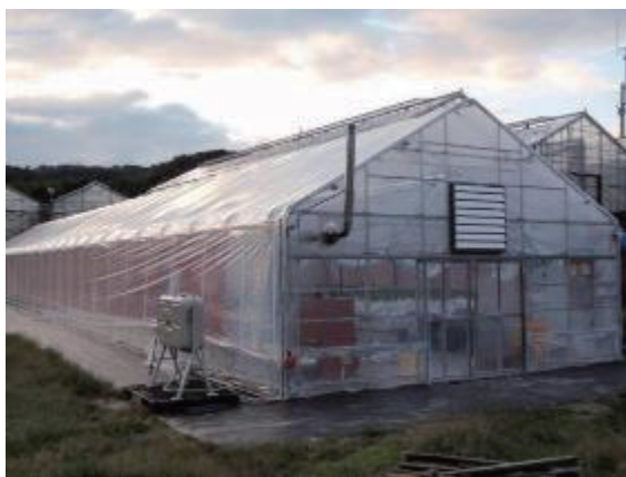
図1 足場パイプハウスと複合環境制御技術の同時導入の実証状況
