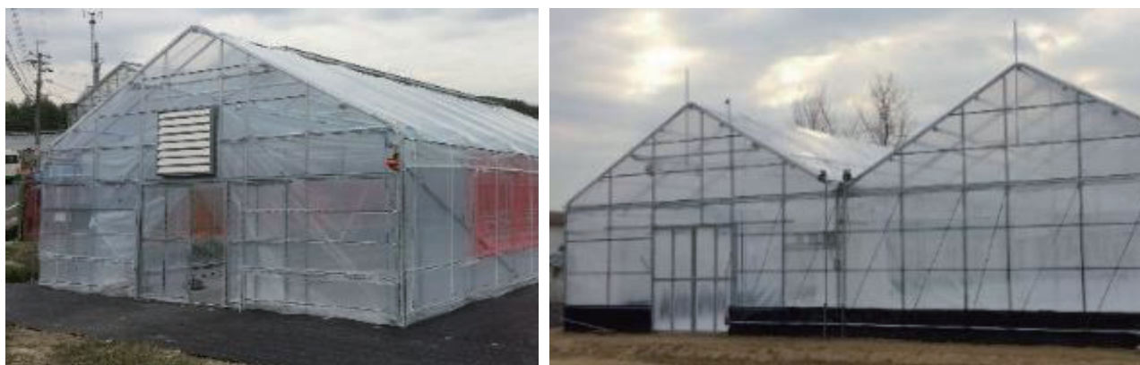
図1 6.5m間口の建設足場パイプハウス (右)単棟型 (左)連棟型
