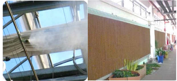
写真1 細霧冷房（左）およびパッドアンドファン（右）
