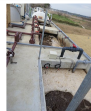
検証実験予定の養豚農家の活性汚泥処理施設の曝気槽
