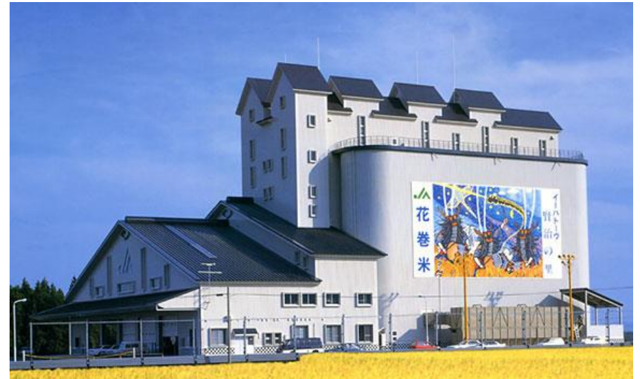
カントリーエレベーター
