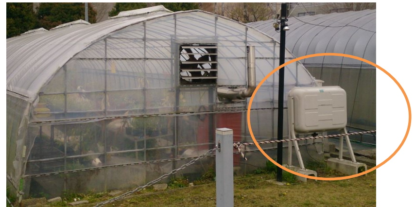
灯油加温器⇒バイオマス化(燃料代削減)
