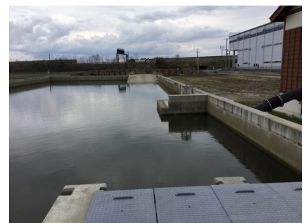
図1 配水槽式自然圧パイプラインシステムの配水槽
