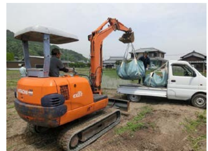
写真4 バックホーによる積込
