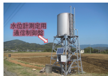
配水槽の監視状況
