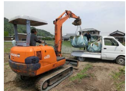
写真4 バックホーによる積込
