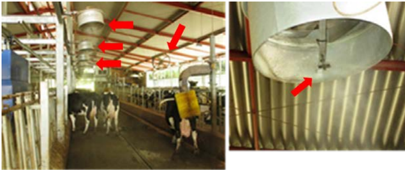
図5. 自動環境調整装置によるファンと散水システム(矢印)
