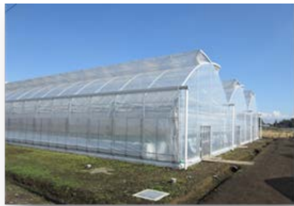
写真3 栃木実証圃の外観
