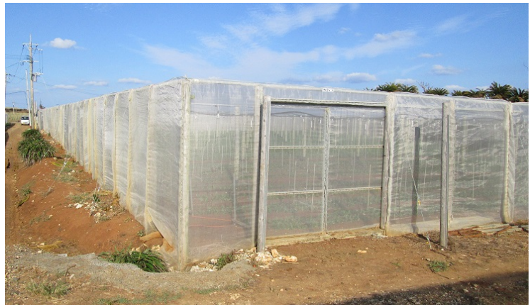
写真1 鉄骨平張施設
