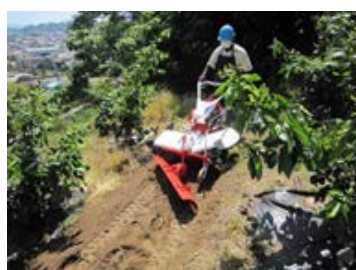
写真 作業道造成機による小規模園内作業道の造成
