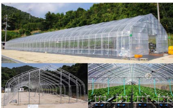
図1 実証栽培施設の外観(上)とダブルアーチ構造ハウス(下左)と多植栽培システム(下右)
