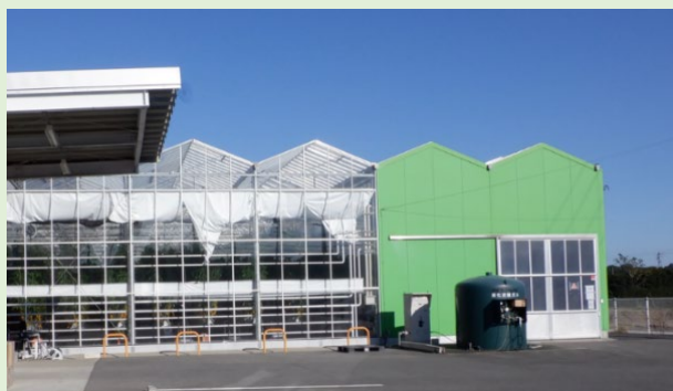
本社に隣接して建つ環境制御型ハウス
