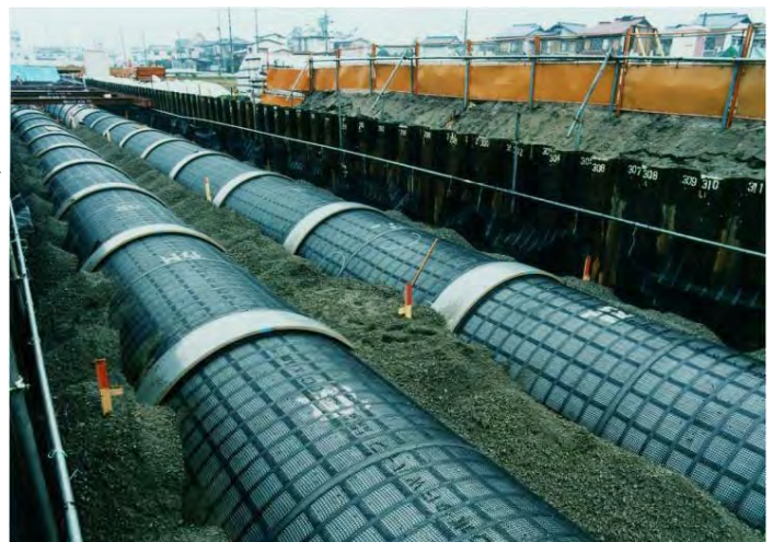
ジオグリッドを用いた浅埋設工法による大口径パイプラインの敷設
