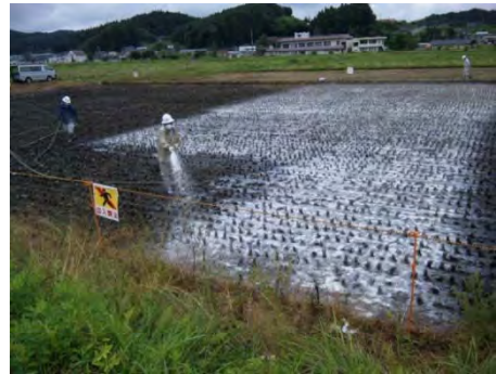
固化剤吹き付け作業
