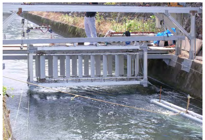
開発した水車の設置状況
