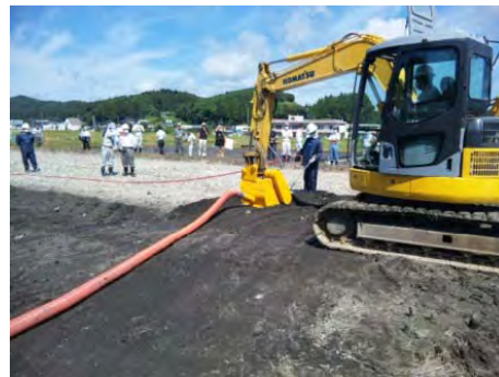
固化後の表層土の削り取り作業状況
