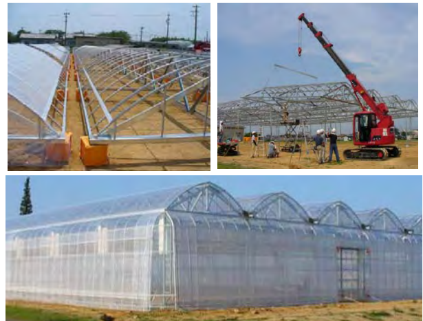
図1 屋根ユニット工法による超低コスト耐候性ハウス
