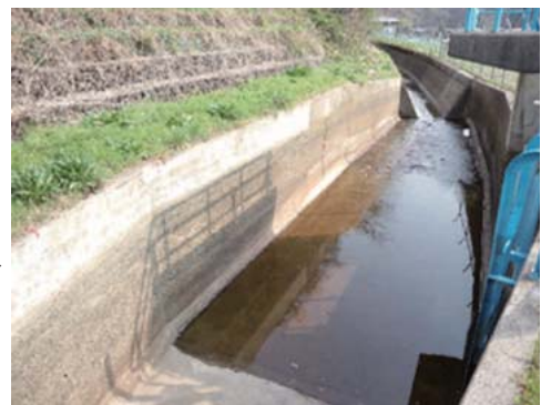
水路除染後の様子→ (余水吐)
