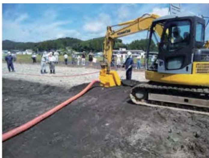
ワイパー工法+バキュームカーで吸引 (削り取り、集積、搬出が1工程で可能)
