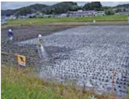
固化剤の吹きつけ作業
