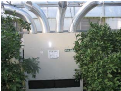
農業用ヒートポンプの例
