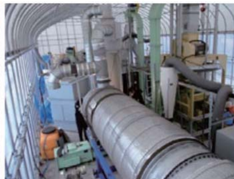
減容化設備全景（幅7m、奥行20m） と製作したペレット（右）
