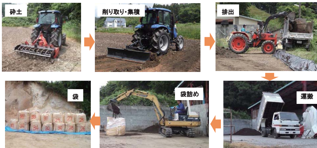
農業機械による圃場表土除去作業手順
