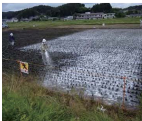
固化剤の吹きつけ作業と固化後の状況
