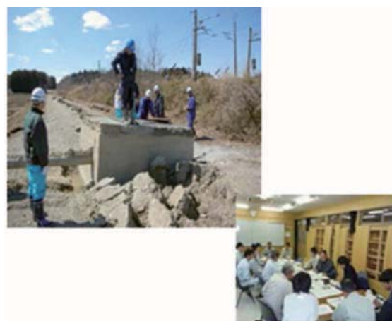
福島県のパイプラインの被害調査
