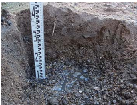
←余水吐掘込部の堆積物の状況
