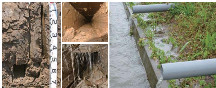
グライ土での施工状況 (上：施工後、下：2年目)
