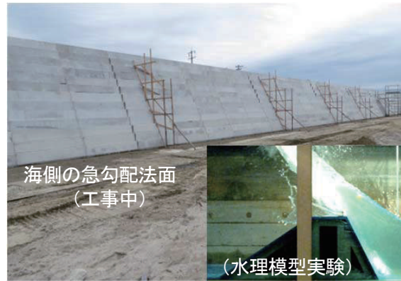
防潮堤工事で採用された粘り強い盛土工法
