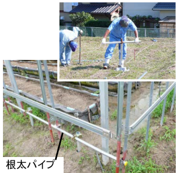
スパイラル杭の打設方法と既設ハウス補強
