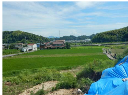
写真-1 6 崩壊箇所から下流側を撮影
