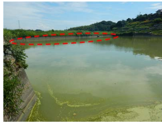
写真-1 4 堤体内法のコンクリート擁壁
