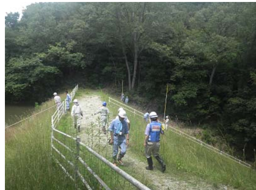
写真-2 堤体右岸側から東側堤体を撮影
