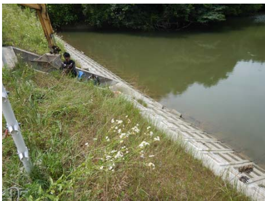
写真-5 貯水の状況（南側堤体にて）
