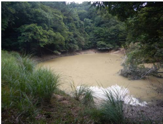
写真－21 貯水の状況
