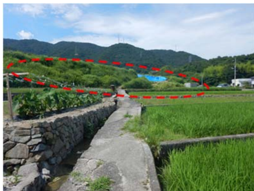
写真-1 5 正面堤体を下流側から撮影
