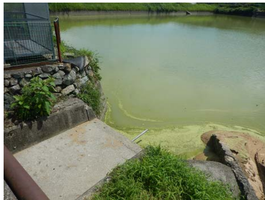
写真-1 3 半三池の水路流入型の洪水吐
